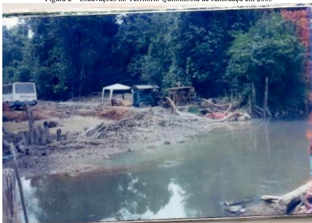
Figura 2 – Escavações no Território Quilombola de Jambuaçu em 2005
